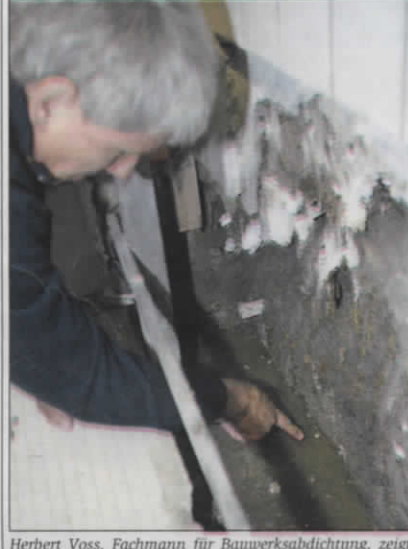
Herbert Voss, Fachmann für Bauwerksabdichtung, zeigt
